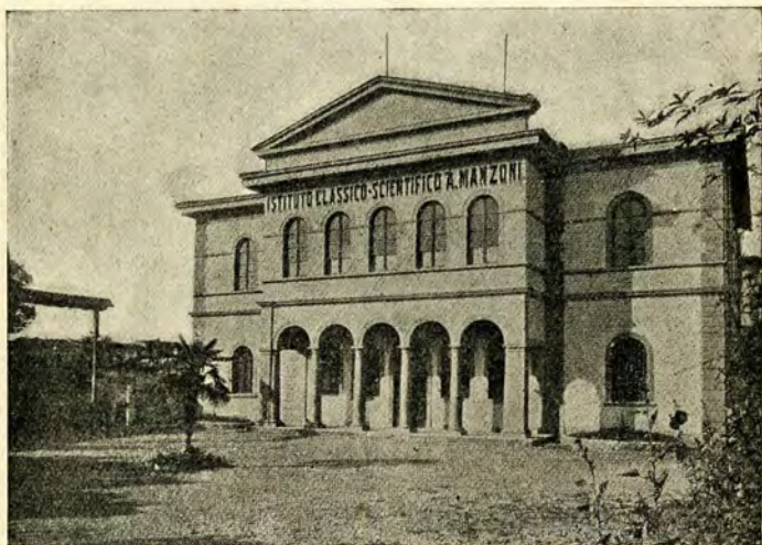
La facciata dell'Istituto con il grande piazzale.
